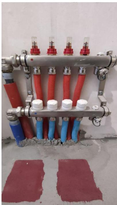
В случае аварийной ситуации отключение подачи теплоносителя в квартиру производится путем перекрытия отсекающего устройства в коллекторном узле квартирного холла. Отсекающий вентиль подписан для соответствующей квартиры.
